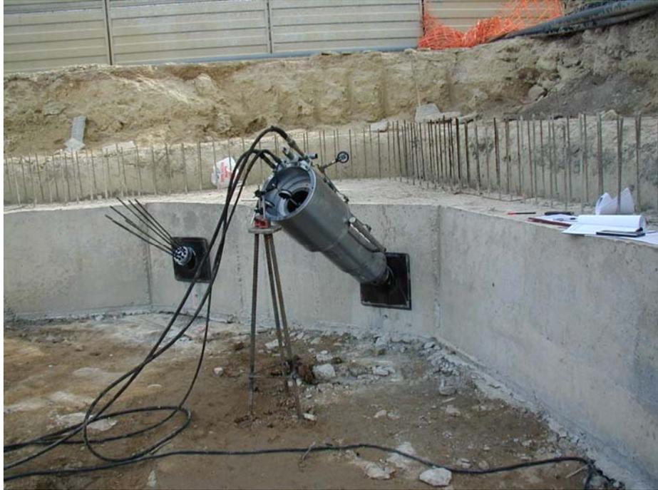
**Figura 24: Detalle de gato de tesado (U&A).**
