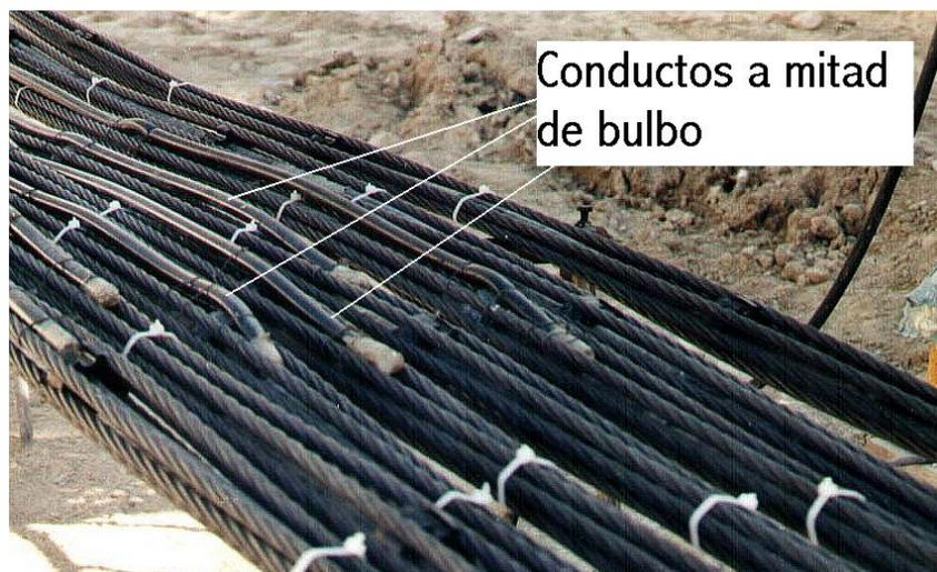
**Figura 18: Conductos para inyección repetitiva IR.**
