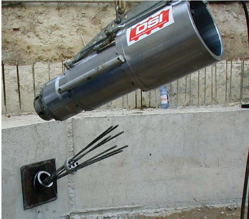
**Figura 13: Fotografía de un anclaje de 7 cables en la coronación de una pantalla. Se observa la placa de reparto mecanizada para conseguir la inclinación deseada, y el portacables. En la parte superior, un gato hidráulico para el tesado (U&A).**
