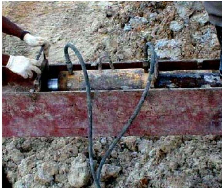
Figura 17: Trabajos de ejecución de anclajes tipo “jack-in”.
